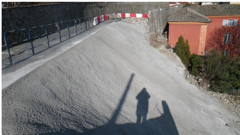
**Figure 15:** *vue de la portion de D28E effondrée encours de réparation*
