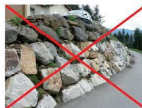
Exemple d'enrochements de type cyclopéen
