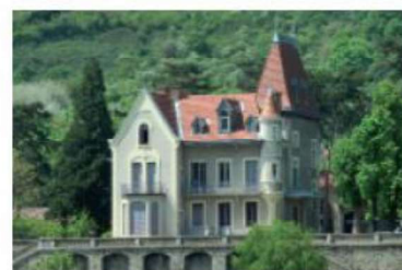
Exemple de toiture de maison bourgeoise
