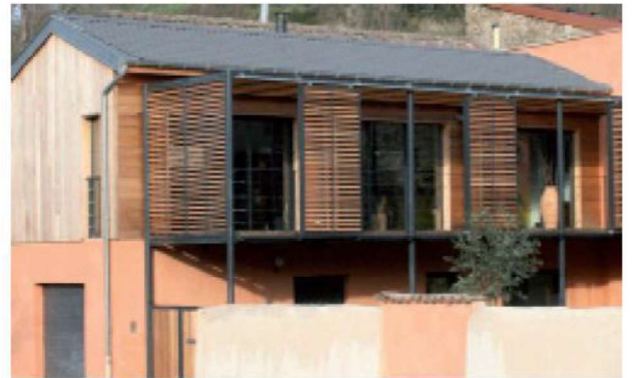
Exemple de loggia
