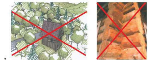
Exemple de construction de type « chalets » et madriers à assemblage croisé
