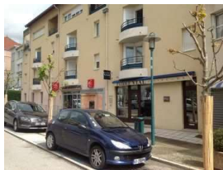
Immeuble récent contiguë au centre-ville
