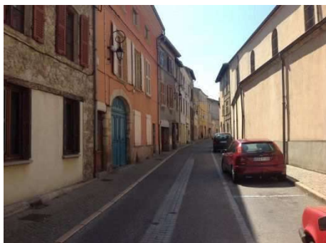
Bâti ancien du centre-ville
