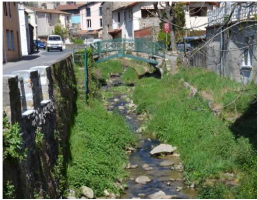
Passage de l'Arbuel dans le centre de Condrieu
