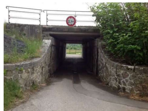
Passages étroits sous la voie ferrée
