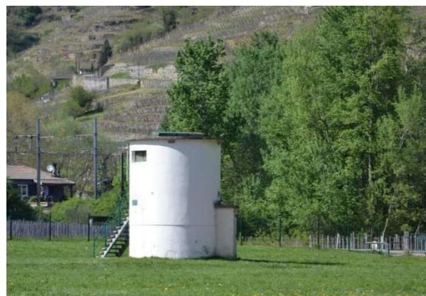
Captage de Bachasse
