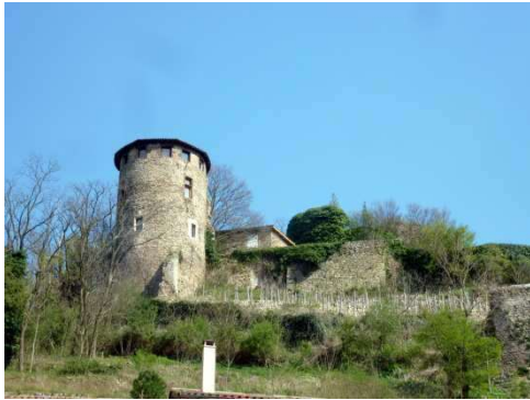
N°17 – Tour Garon et ruines du château
