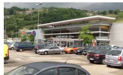
La ZAE commerciale de la Maladière
