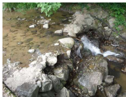
Obstacle à l'écoulement des eaux
